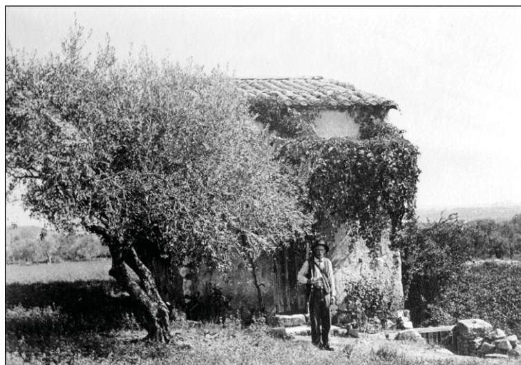
mazet de Louis Espérandieu (quartier Moulin à vent) - 1934
