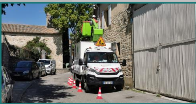
Rénovation de l'éclairage public : grand rue et rue du temple
