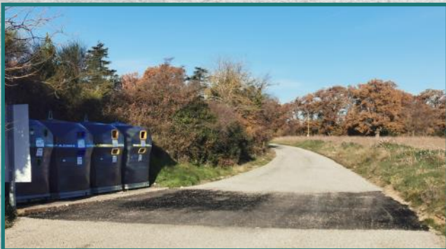
Aureilhac : Ancien chemin d'Alès à Blauzac - revêtement tri-couche sur l'ensemble du chemin.
