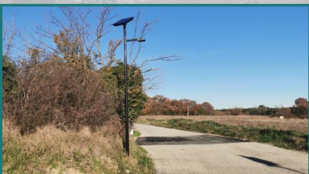
Rénovation de l'éclairage public : éclairage solaire à Aureilhac et parking du stade
