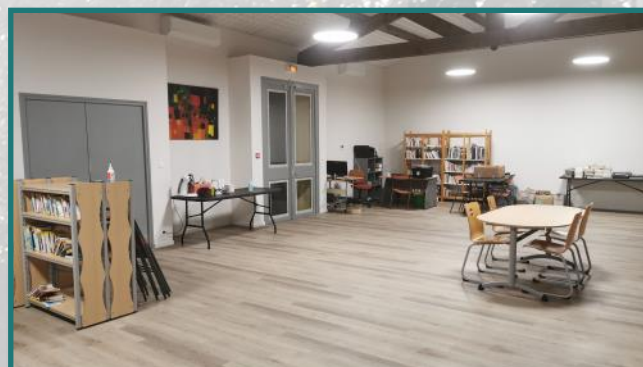
Travaux de réaménagement et de mise en accessibilité de la future bibliothèque (salle polyvalente).
