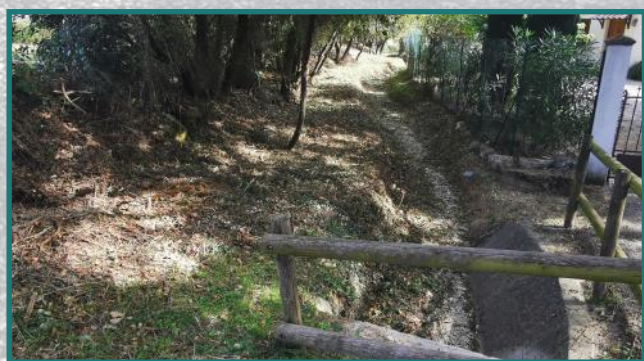
Nettoyage, débroussaillage puis recalibrage du fossé nord entre le chemin Cantarel et de la Barboye.
