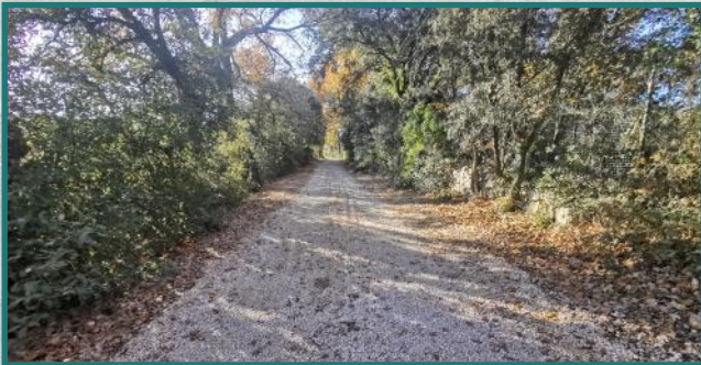
Chemin du Pré de Miere : revêtement en concassé aux abords du camping.
