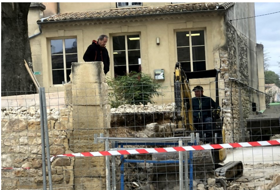
Bernard MOLOT au plus près des travaux
