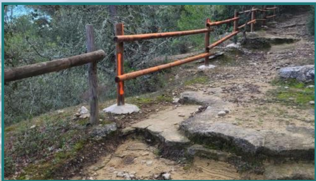
Protections en bois / sécurité
