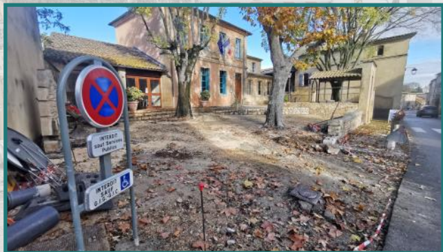
Place de la mairie - travaux en cours
