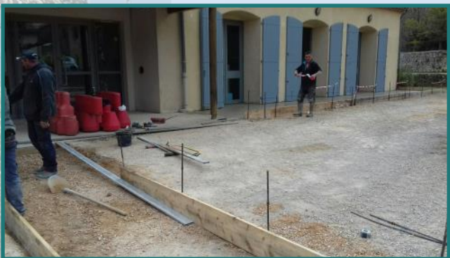
Travaux accès PMR salle polyvalente et bibliothèque
