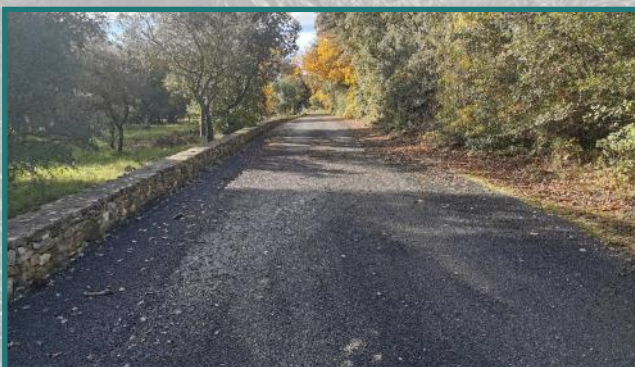
Travaux sur les chemins
