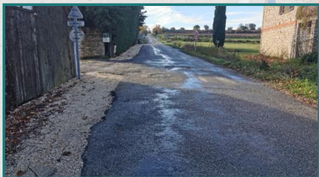
Parking route vieille - travaux en cours
