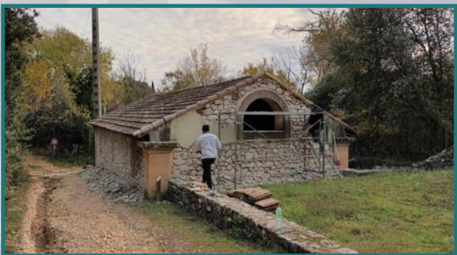
Travaux en cours sur le lavoir
