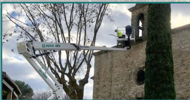
Travaux d'élagage - Grand'rue et rue du temple
