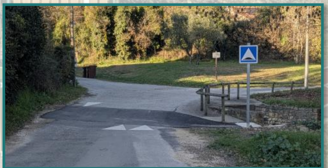
Entretien et aménagement de voies (photo : Fontèze)
