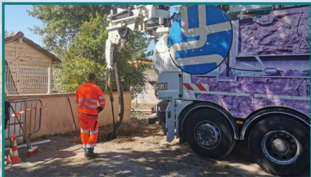
Curage du réseau d'assainissement
