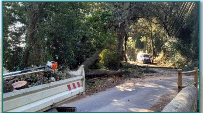
Travaux d'élagage par les agents du service technique
