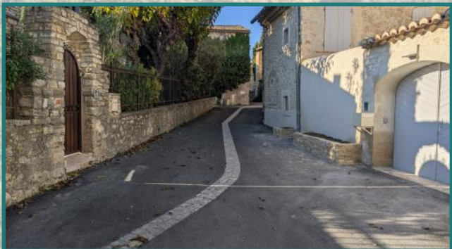
Travaux de voirie à Aureilhac
