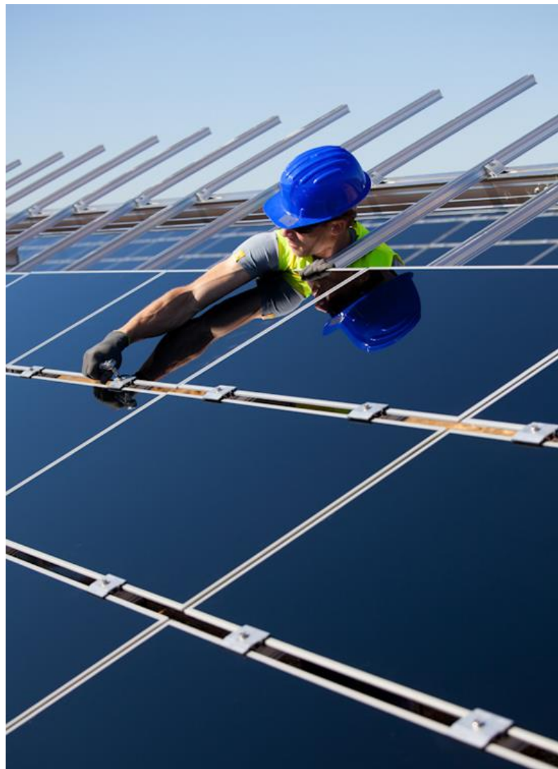
Remplacement de module (crédit photo EDF power solutions)
