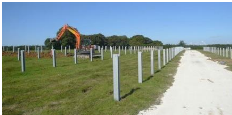
Travaux de montage des supports des modules (crédit photo : EDF power solutions)
